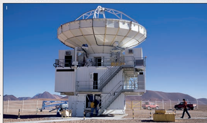
I — APEX (Atacama Pathfinder Experiment) — радиотелескоп, расположенный на высоте 5100 м над уровнем моря в обсерватории Льяно де Чахнантор (Llano de Chajnantor) в пустыне Атакама на севере Чили, в 50 км к востоку от Сан-Педро-де-Атакама. Основная «тарелка» телескопа имеет диаметр 12 м и состоит из 264 алюминиевых панелей. Телескоп официально открыт 25 сентября 2005 г. APEX является модифицированным прототипом антенны ALMA и находится на месте будущей большой радиоастрономической обсерватории. Он способен найти немало объектов, которые позже можно будет подробнее изучить при помощи ALMA. Телескоп APEX создан для работы в субмиллиметровом диапазоне (длина волны 0,2-1,5 мм), простирающемся между инфракрасным излучением и радиоволнами. Субмиллиметровая астрономия дает возможность исследовать холодные удаленные пылевые облака, но слабые сигналы
